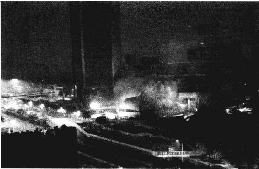
图 1.3 广州天河城西塔楼环保清洁爆破拆除瞬间
