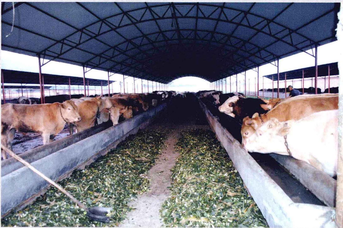
山西光华铸管有限公司在文水县南武乡投资建设的养牛场。
