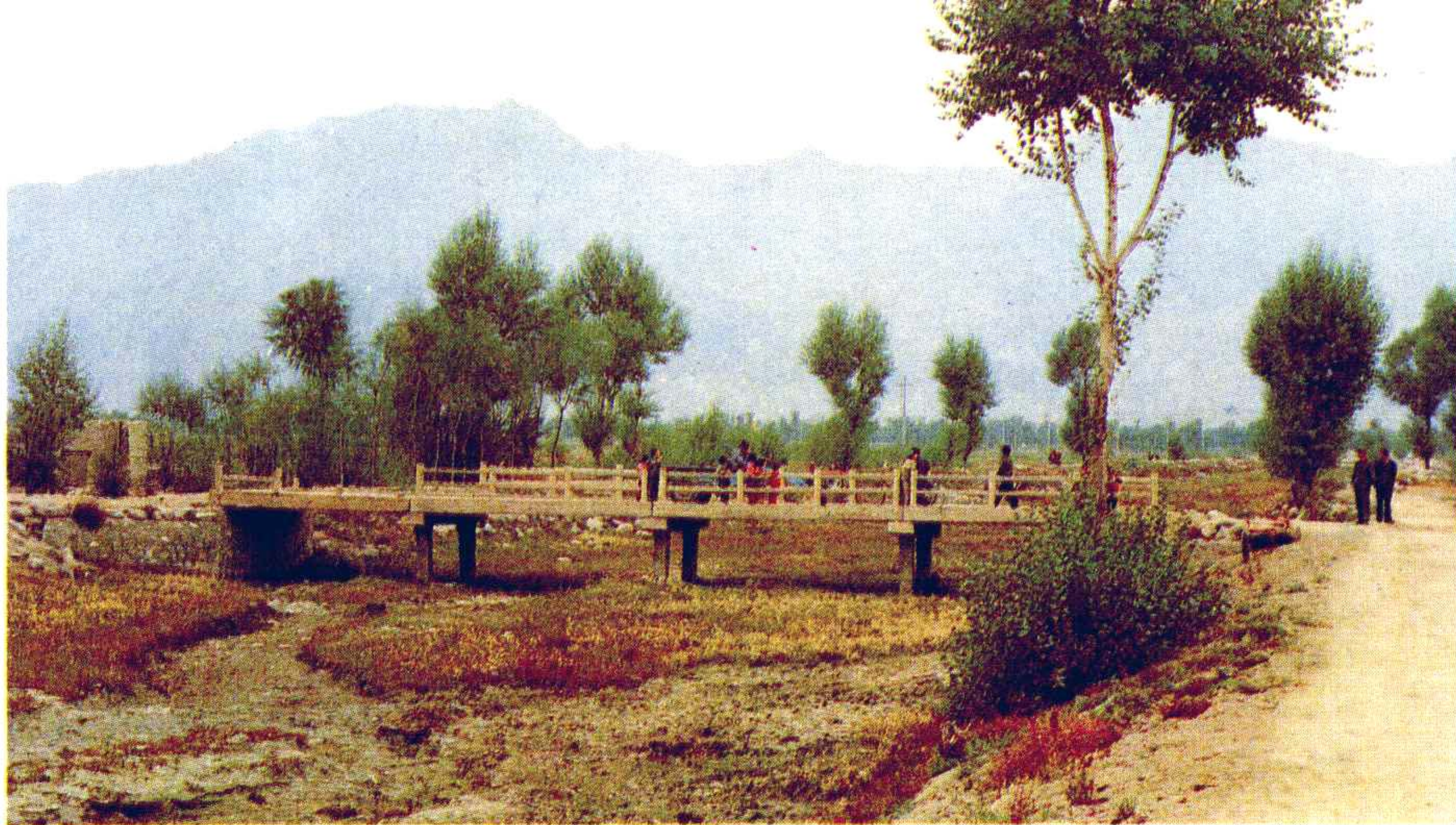
二号导洪沟桥
