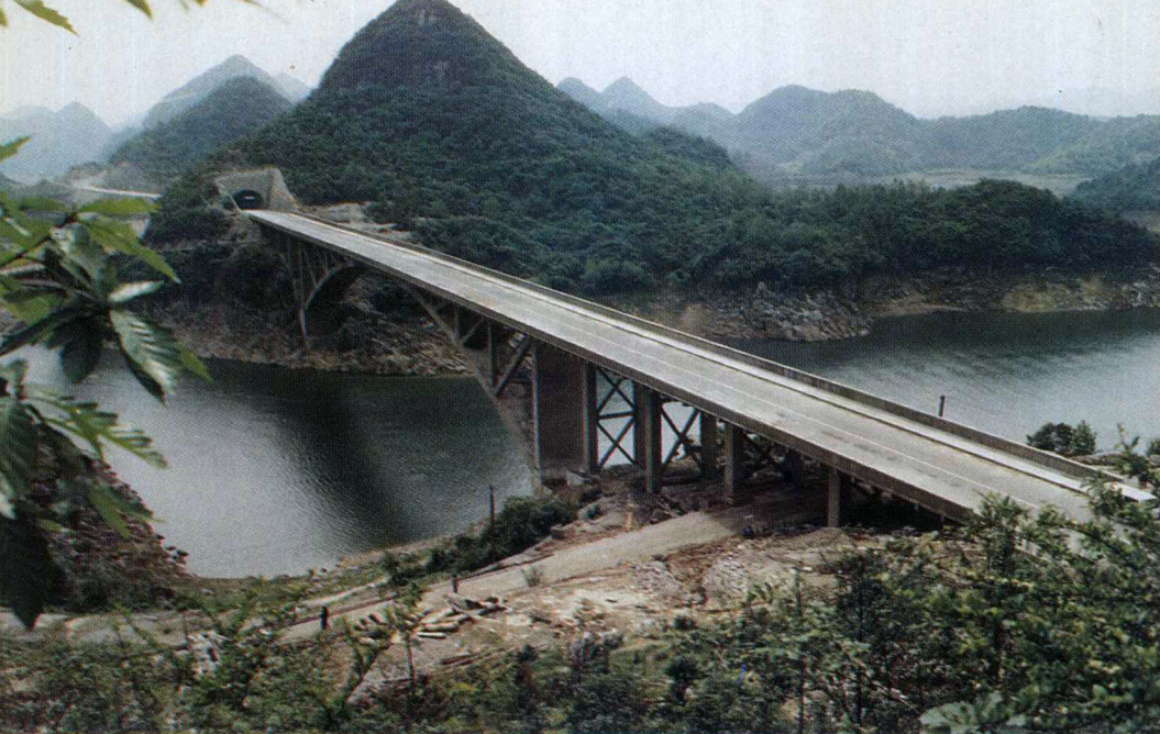
上、贵黄公路上单跨150米的清镇花鱼洞大桥横卧山青水秀的红枫湖。
