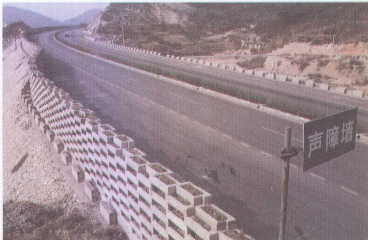
中国公路第一墙——贵黄公路贵州工学院路段声障墙。
