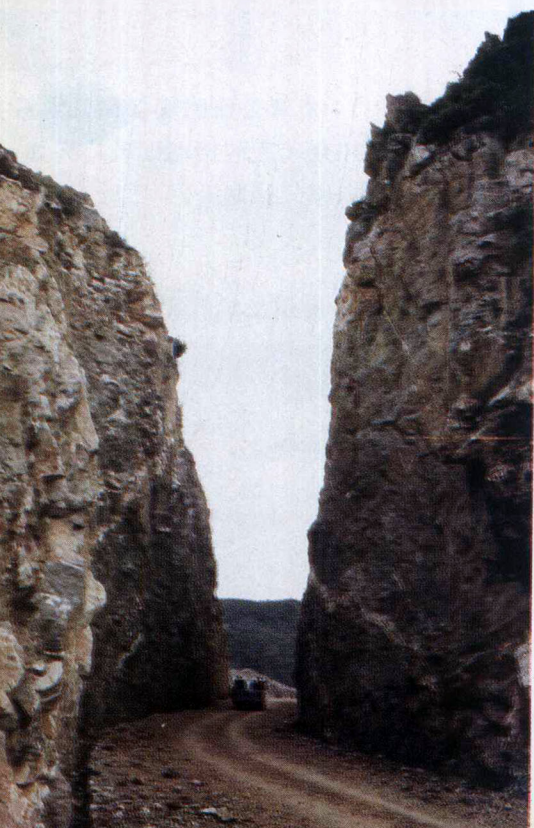
下、粮棉布公路兴义棒鲂至养马路段大拉槽。
