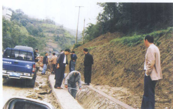
正在施工的凯(里)施(秉)线路基施工
