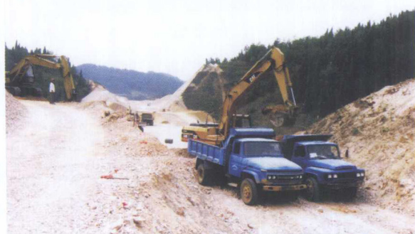
正在施工的凯施线路基工程
