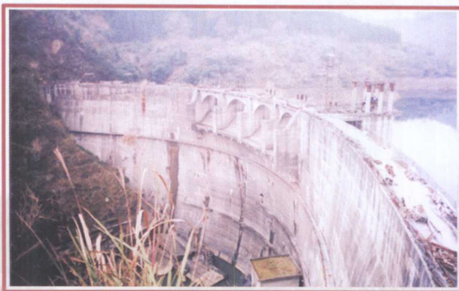
正在加高的黎平县双江电站抛物线双曲拱坝
