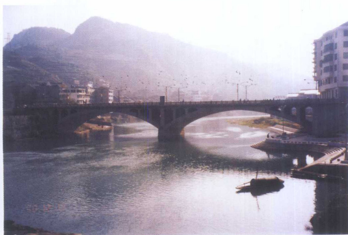
镇远西门大桥
