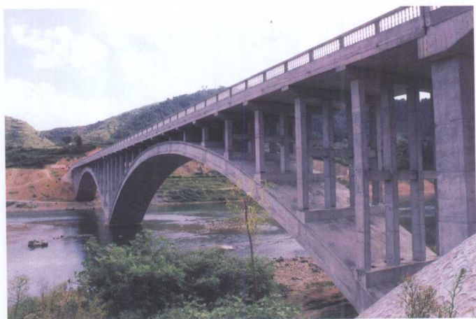
新建成的施洞大桥
