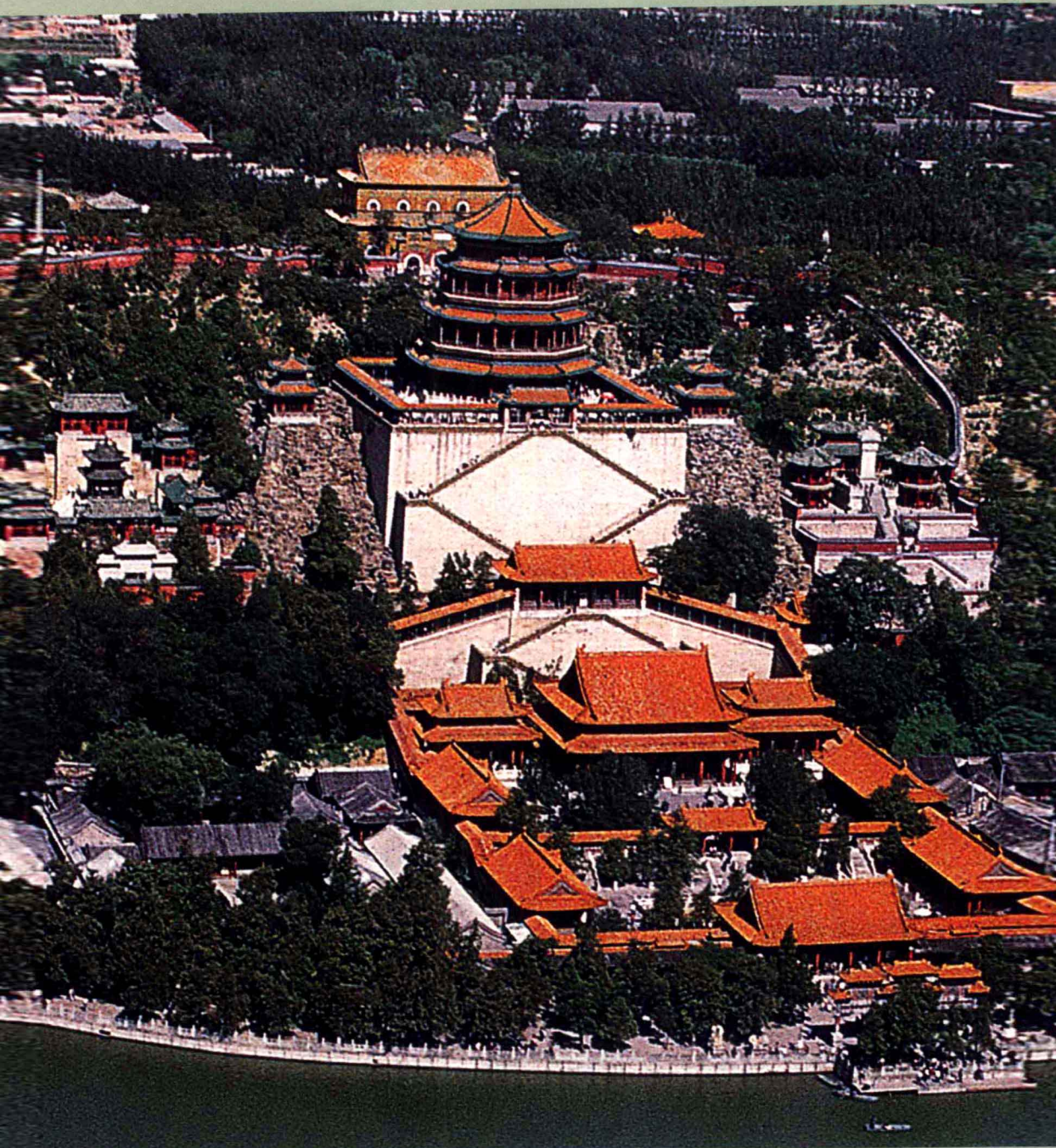
北京颐和园排云殿建筑群
