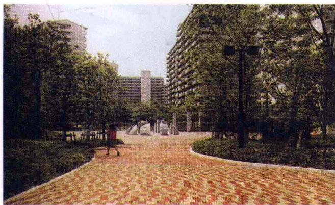
图3-11 居住区人行道铺装
