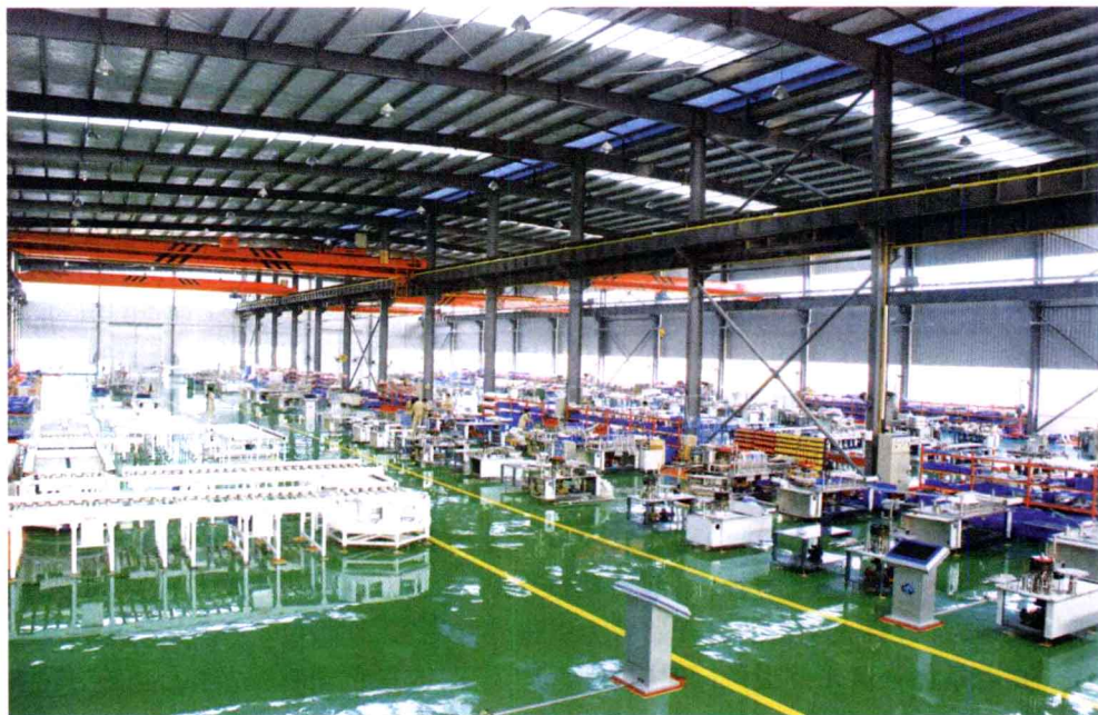
楚天科技股份有限公司数字化装配车间
