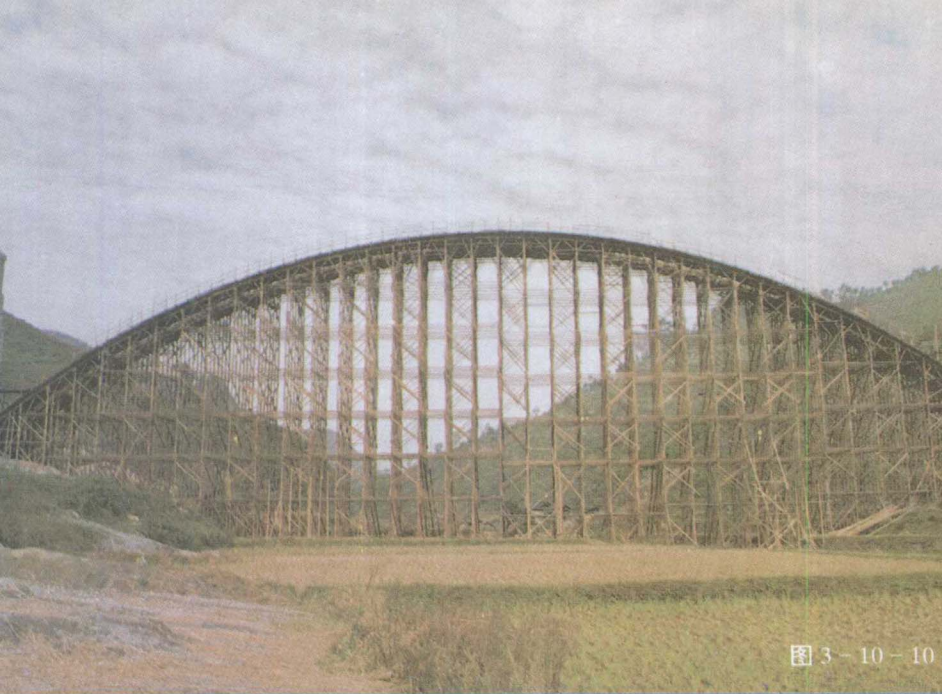
图 3-10-11 鸟巢河大桥裸拱卸架
