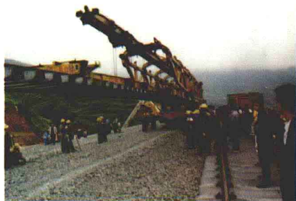
内昆铁路彝良段建设（左：铁路工人正紧张地铺轨， 右：大寨火车站建设。）（梅文义、陶爱贤）
