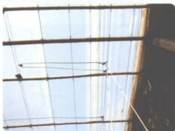
彩图2-7 通过天窗通风滑轮开关通风口
