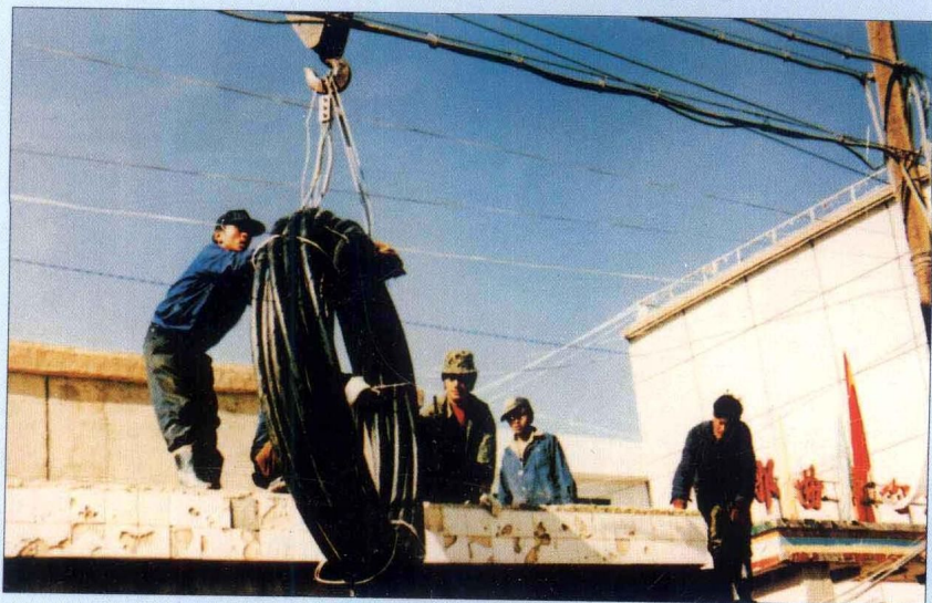
▽ 外线人员正在抢修电缆线路
