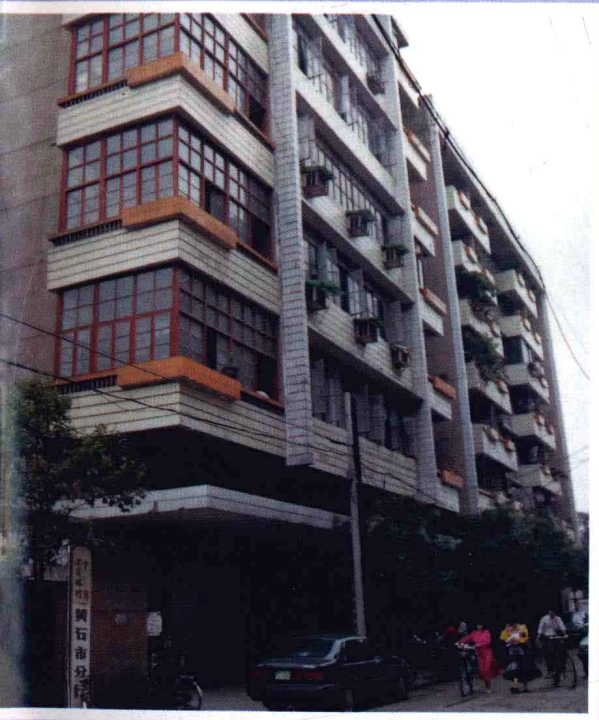
分行现办公大楼
