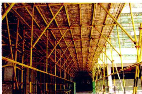
施工安全通道
