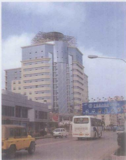
正在建设中的州地税综合办公楼。
