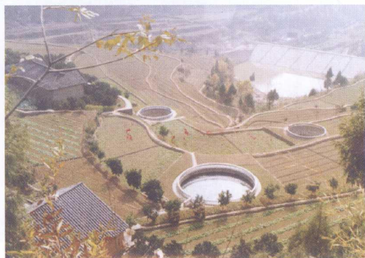
坡面水系工程（四川苍溪）
