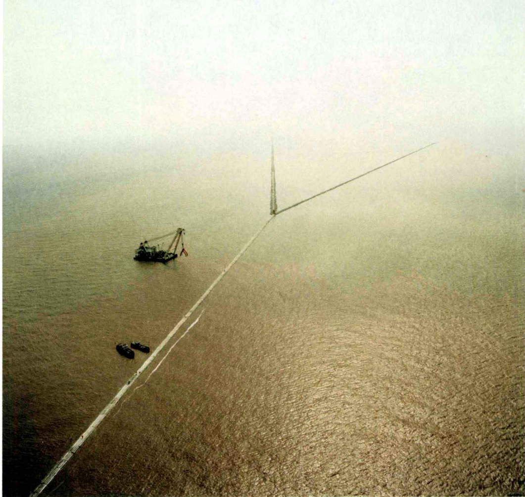
分流口鱼咀工程。由此,长江口南港分为北槽深水航道和南槽普通航道
