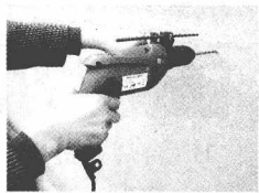
C. 工人用电钻钻墙
