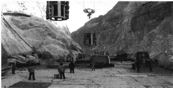
图 1 综合蓄热法在工程建设中的应用
