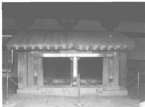
图 1-1 山东长清县孝里镇孝里铺村孝堂山汉石室
