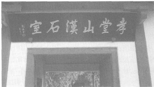
图 1-9 山东长清县孝里镇孝里铺村孝堂山汉石室
