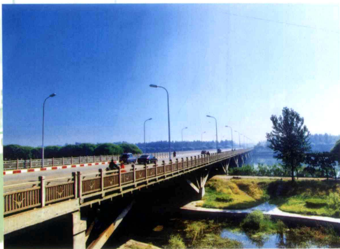
潍临路兴隆大桥
