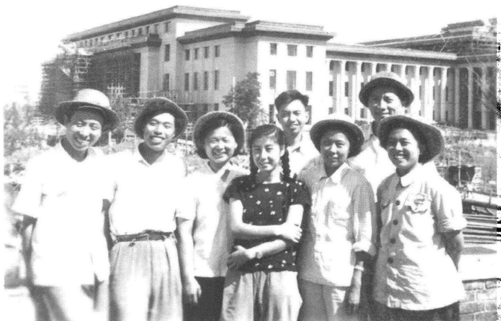
㉑ 1959年，丁一岚（左三）在天安门建筑工地。
