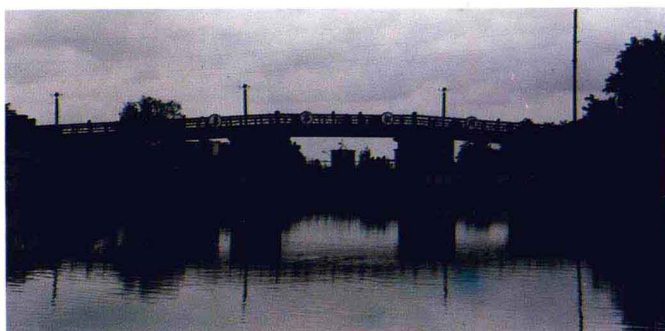
灌溉总渠船闸
