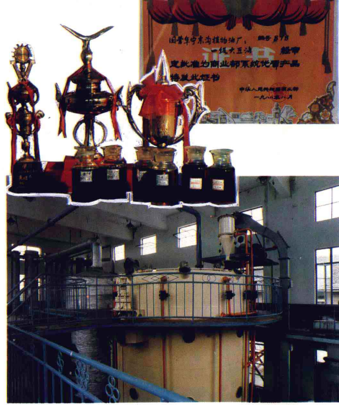
东沟植物油厂浸出车间一角
