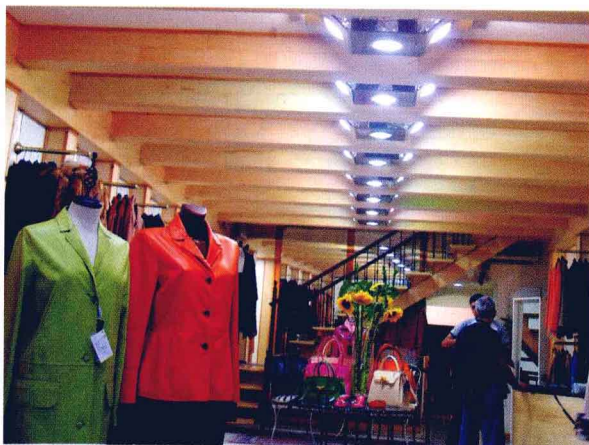
图1-1 采用木饰面材料作为造型的顶棚
