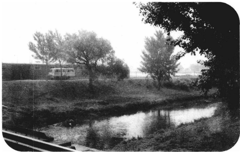
图 1-4 莲花河孟家桥村铁路桥(老莲花河向东拐弯处)
