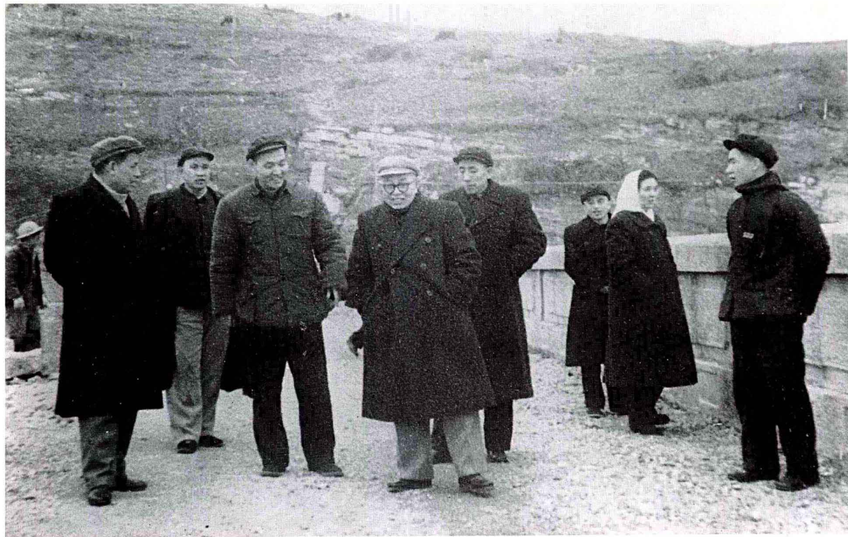
1964年3月，谭震林副总理在贵州视察水利工程。
