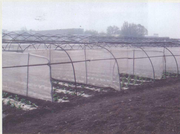
露地塑料隔离墙
