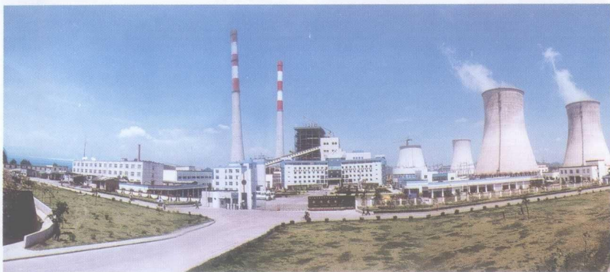
总装机120万千瓦的安顺（普定）火电厂。
