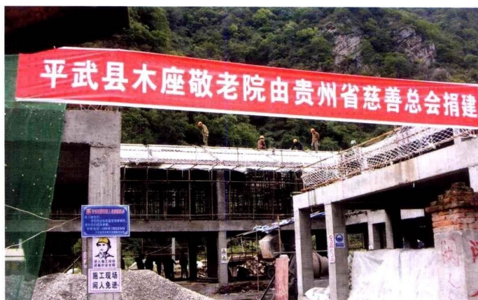
向四川灾区援建的木座敬老院正在兴建中
