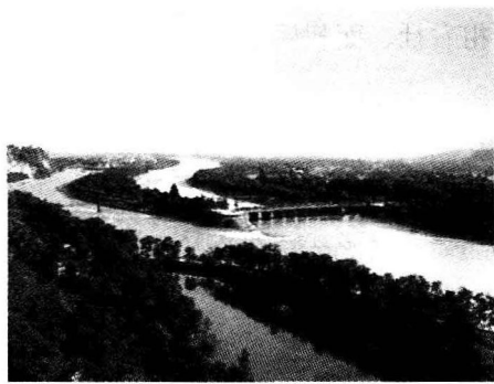
图 1-6 都江堰水利工程
