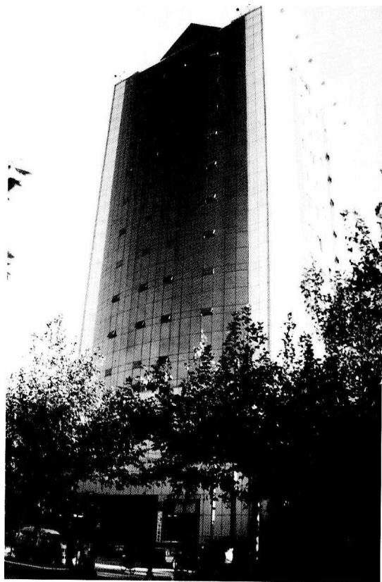
▲ 中国工商银行贵州省凯里分行办公、营业大楼
