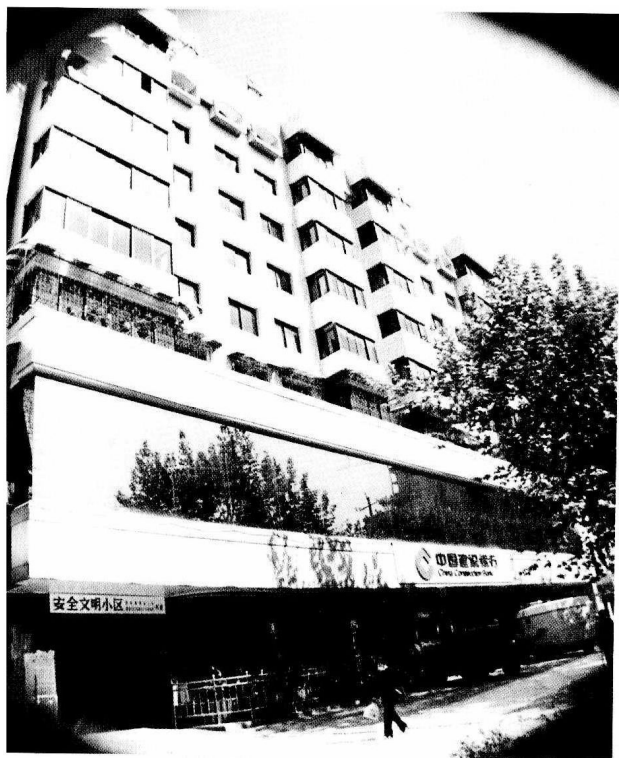
▲ 中国建设银行黔东南州分行办公、营业大楼
