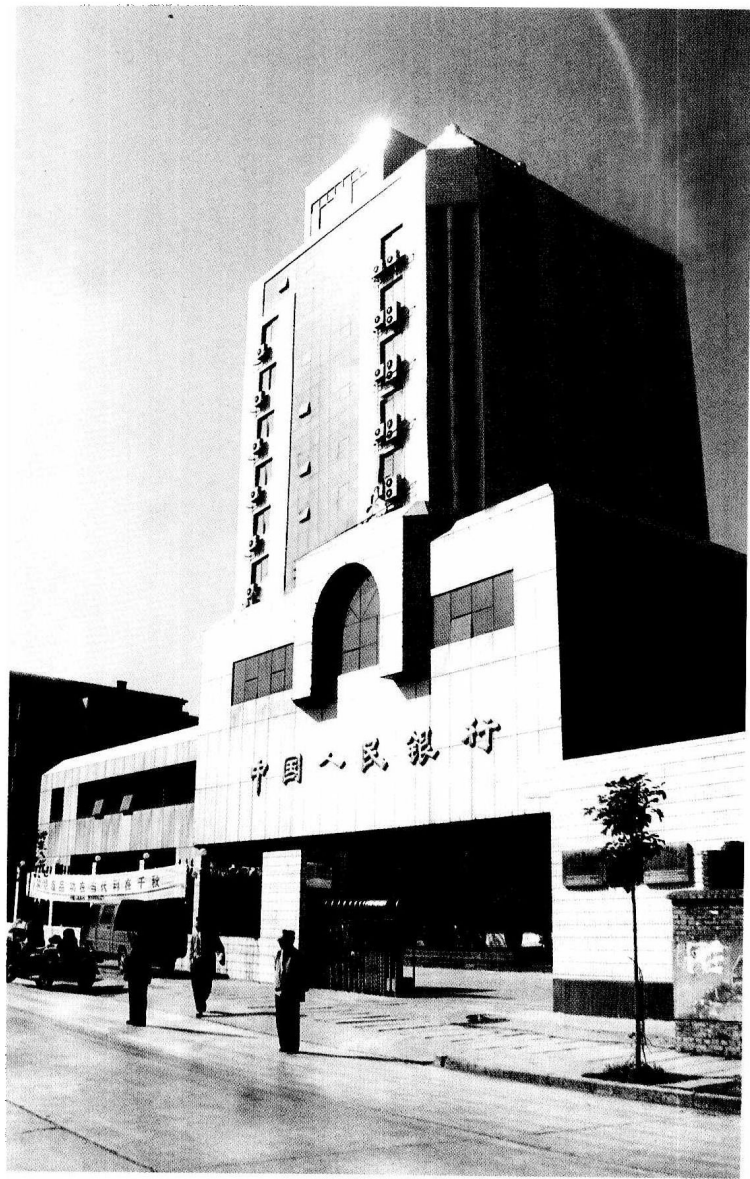
▲ 中国人民银行黔东南苗族侗族自治州中心支行办公大楼
