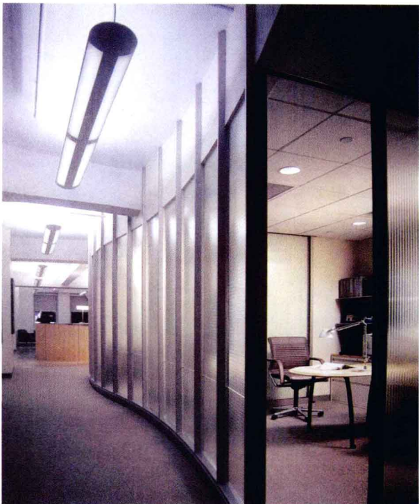
图1-4 采用半透明PVC板隔出的单间式办公室
