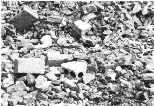
图 1-1 砌体结构拆除物
