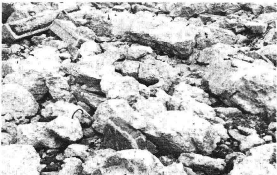
图 1-2 混凝土结构拆除物
