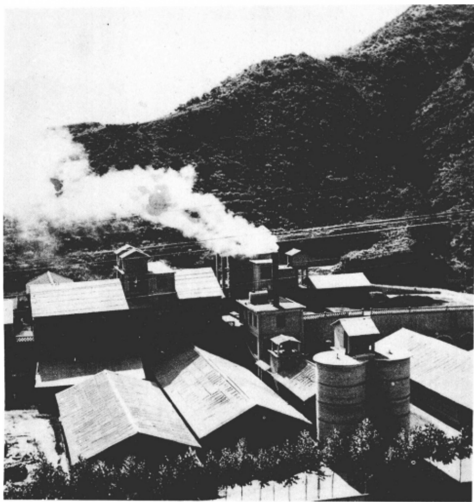
泾源县水泥厂一角
