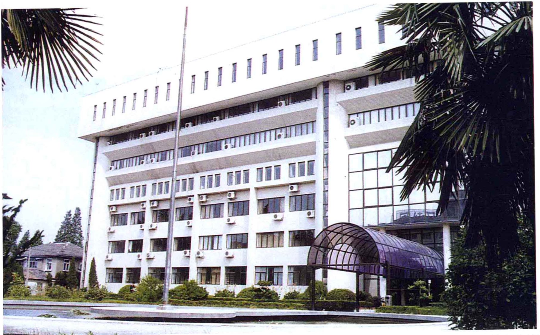
南通市人大常委会、市政府、市政协办公楼
