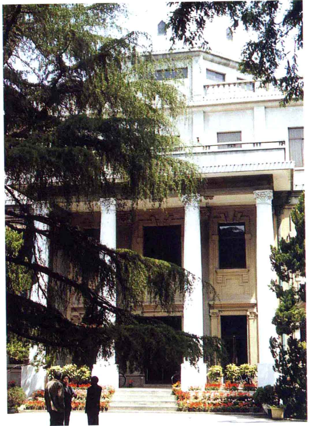
中共南通市委办公楼
