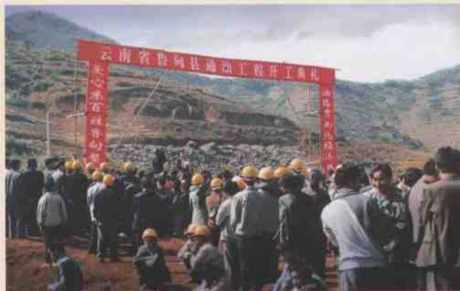
2002年4月23日，全长35.155公里。从县城街心花园至天牛桥的通县油路工程全面动工建设。（马梦麟 摄）
