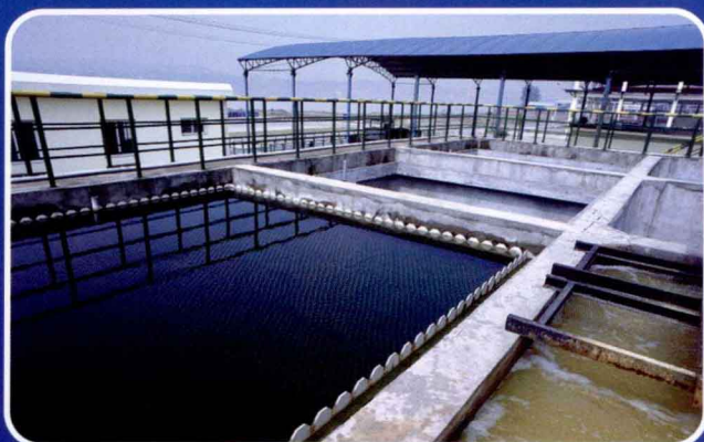
宜昌精细化工园污水处理系统
