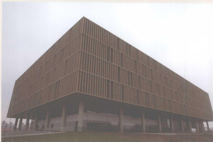
● 建设中的浦东图书馆新馆(陈长华摄)
