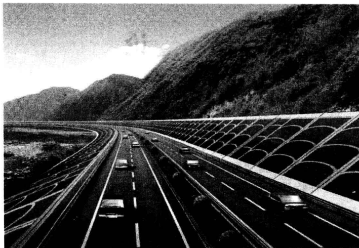
图 0-3 高速公路及边坡防护工程
