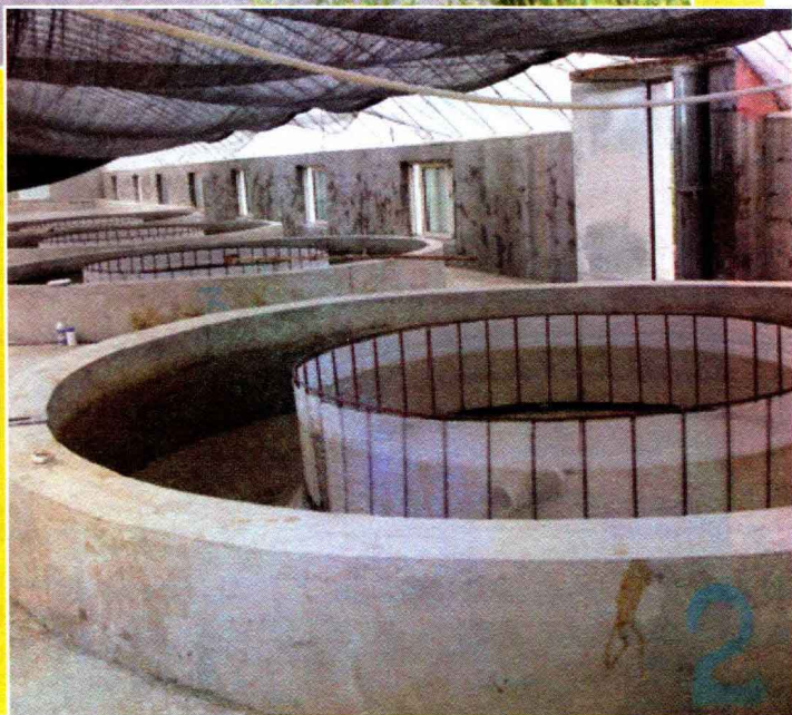
水泥孵化环道
