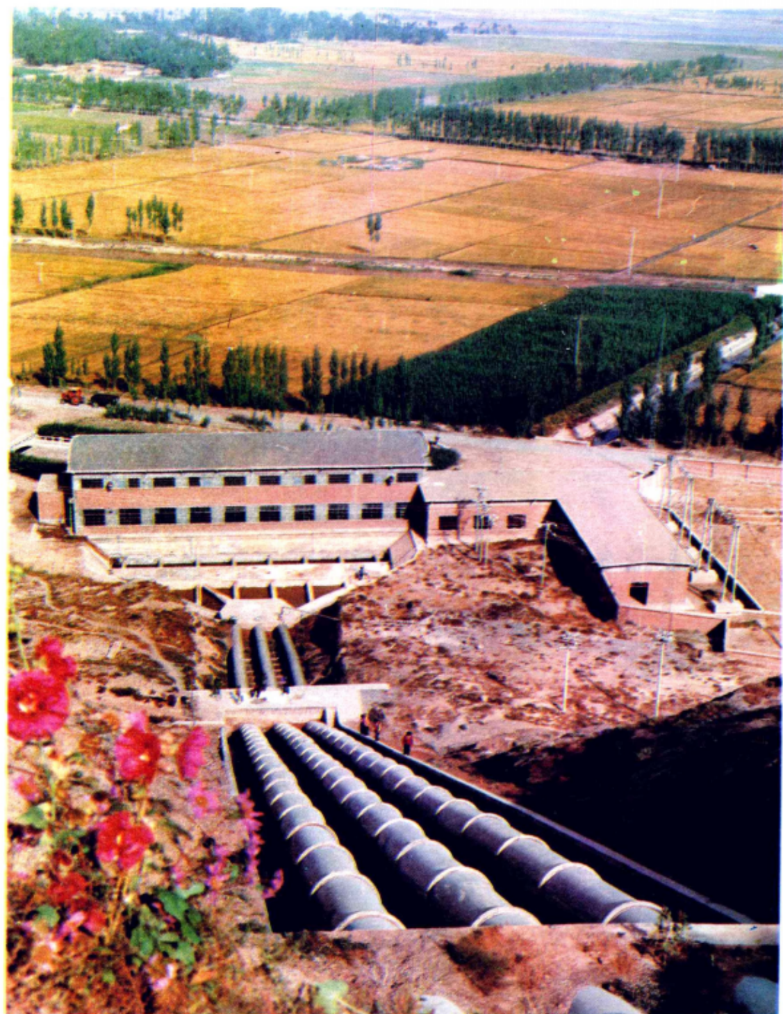
南山台一泵站
