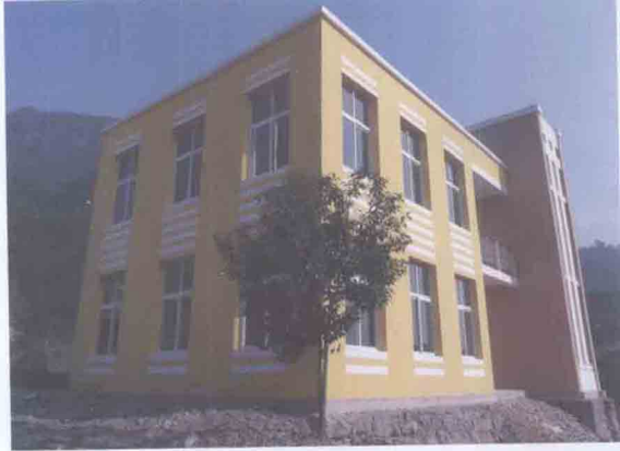
石阡中坝乡综合文化站（2009年）
