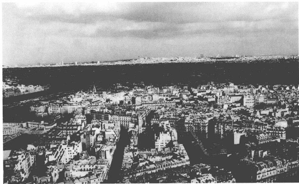
建筑的浑然一体,仿佛是雄浑的音乐交响曲
