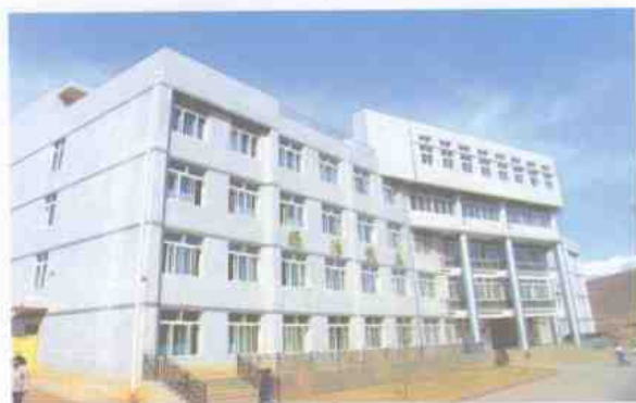
临潭四中教学楼
