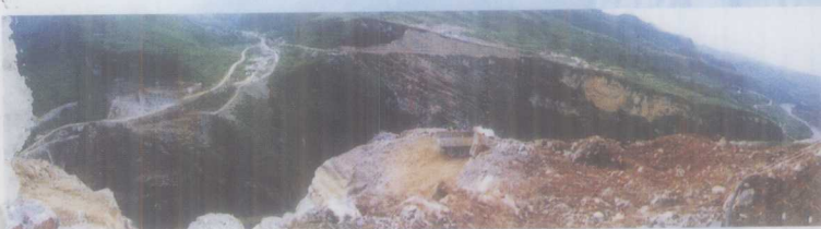
洪家渡电站坝肩开挖
