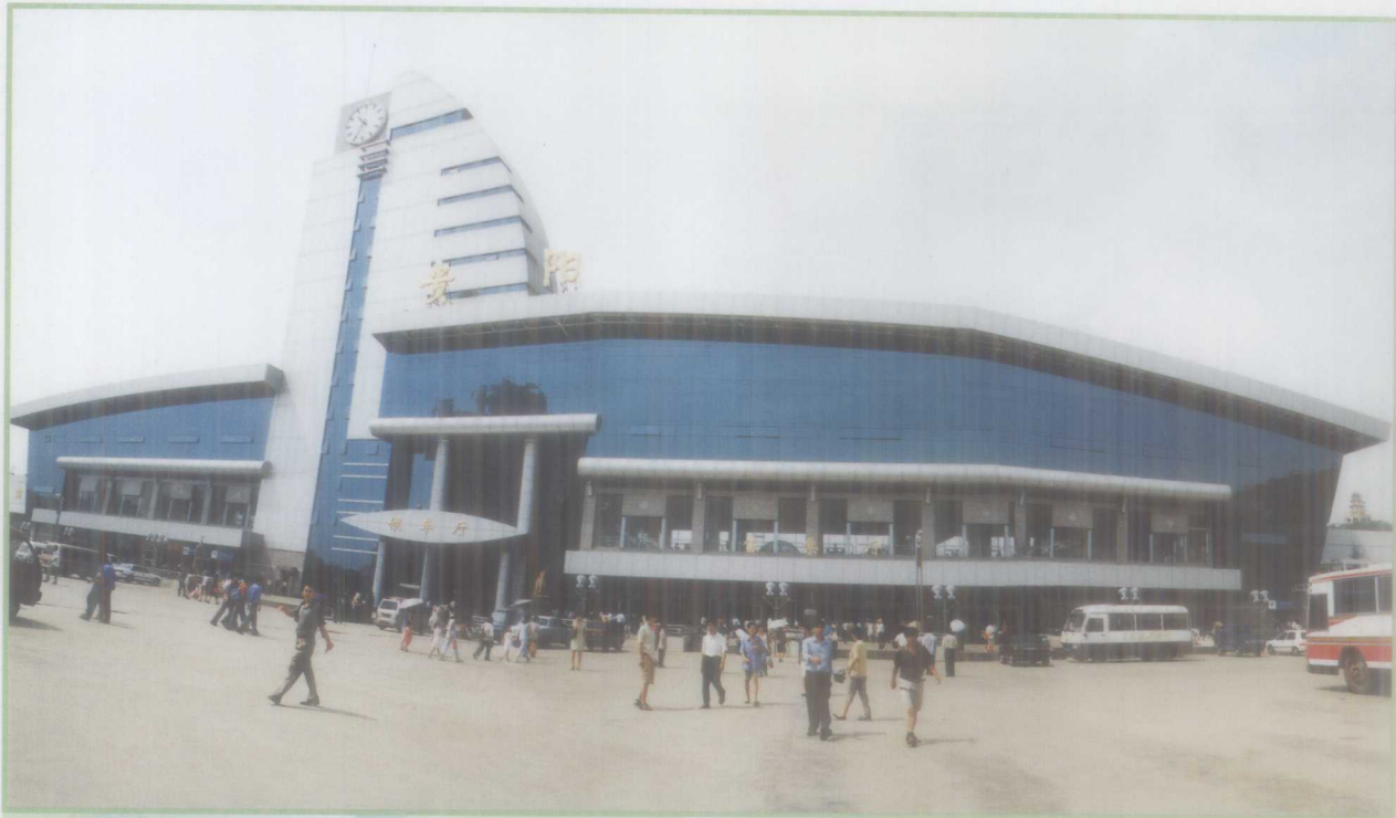
贵阳火车站改扩建工程竣工。图为新站房雄姿(陈听怀摄)
