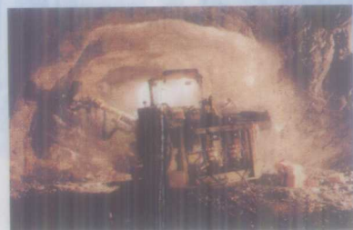
洪家渡水电站导流洞开挖
