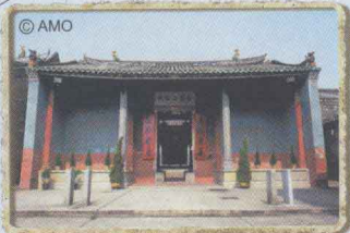
元朗屏山愈喬二公祠 9Md / (241Ln) Yu Kiu Ancestral Hall, Ping Shan, Yuen Long
