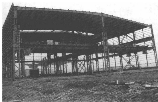
图 1-2 多层钢结构厂房
