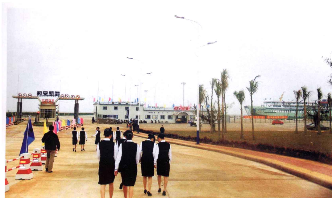
徐闻县海安新港概貌。
