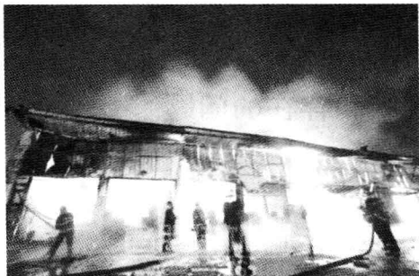
图 1-2 夹芯板结构起火
