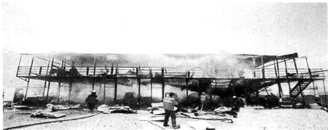
图 1-5 建筑工地活动板房
