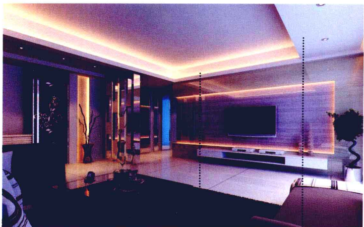
灯带 石膏板吊顶
